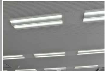
薄形LEDベースライトが配置された天井面
