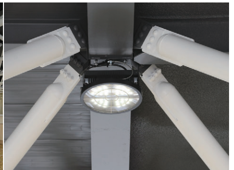
平均消費電力135W、拡散カバー付下面ガードを装備したLED高天井器具
