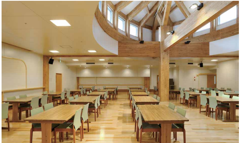
食堂の照明 平天井部にはLEDベースライトとLEDダウンライトを、ハイサイドライト内には電球形スポットライトを採用
