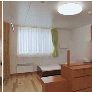
LEDシーリングライトを採用した居室
