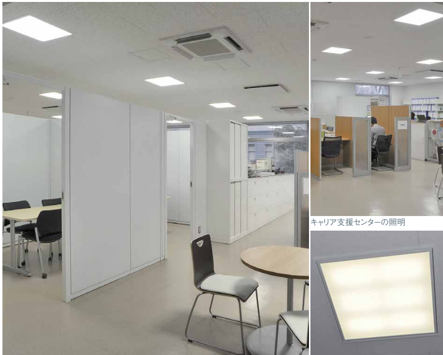
LEDベースライト埋込形スクエアタイプを採用した就職支援センターの照明
