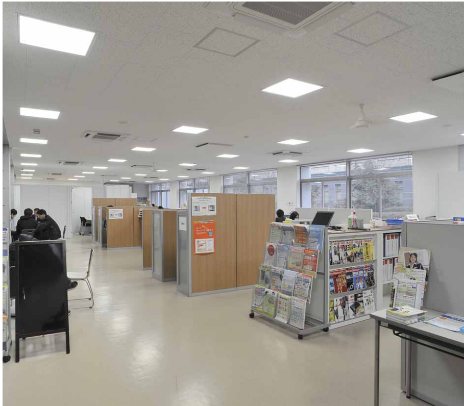
学生支援センターおよび事務室には一体形LEDベースライト埋込形スクエアタイプを整齐配置
