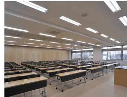
大教室の黒板側から後方へLED照明を望む
