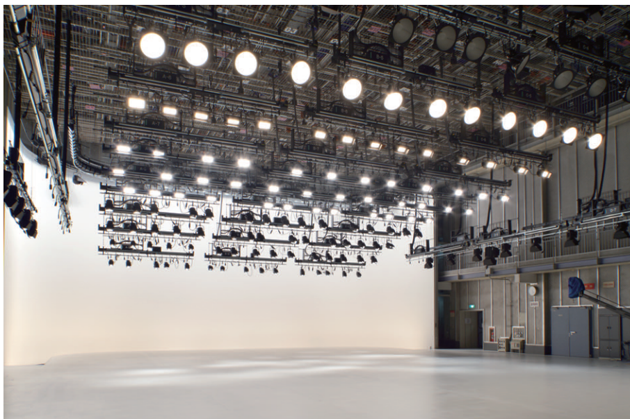
エリアバトン、アッパー・ホリゾントバトン、バックバトン、美術バトン等が整然と並ぶ
