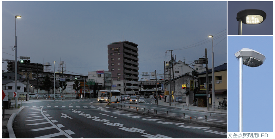
守口市内国道163号線の更新されたLED道路灯
