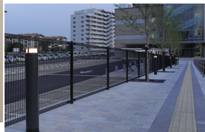
庁舎内歩道のLEDガーデンライトによるアプローチ照明
