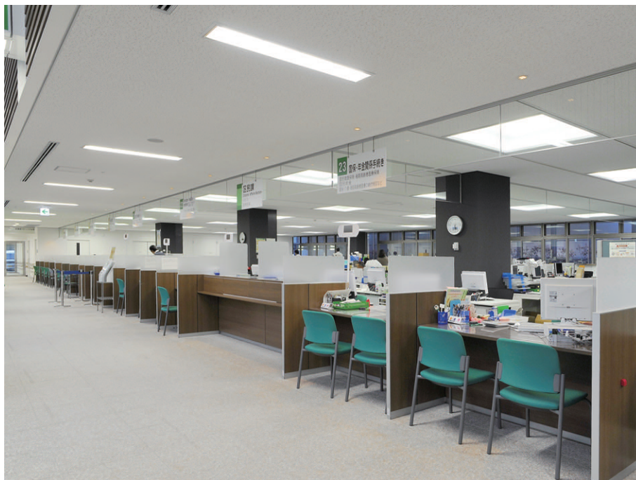
1階窓口業務フロア 執務室には光ダクトによる自然光とLEDベースライト直付形スリムストレートタイプを組み合わせた照明を採用
