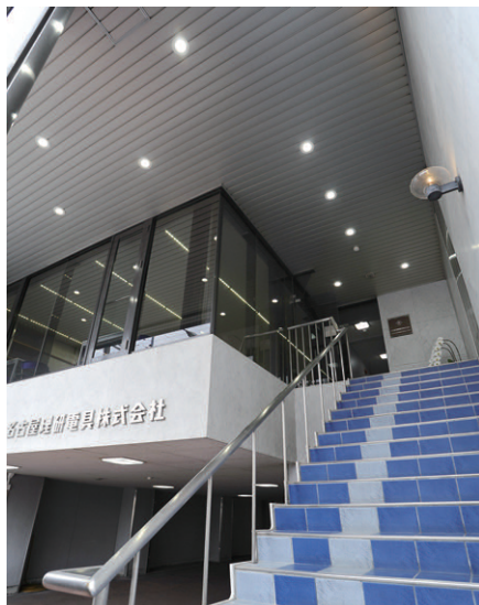
入口部の吹抜け階段のLED照明
