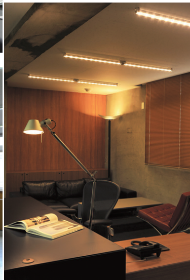
LEDライン器具電球色による応接エリアの照明
