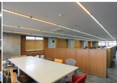
打合せコーナーから執務エリアを望むLEDライン器具による照明
