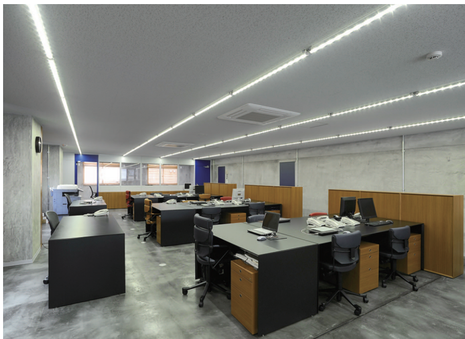
2階オフィス LEDライン器具昼白色を採用し、器具の存在感を薄くして、すっきりした天井意匠にしながら省エネを実現
