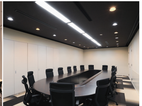
一体形LEDベースライトストレートタイプとLEDダウンライトによる“ROOM7”の照明
