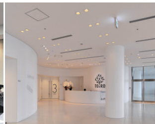
LEDライトエンジンダウンライトによるロビーの照明(写真は3000K・中角)
