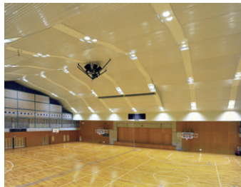
舞台を正面奥に望むLED高天井器具による照明
