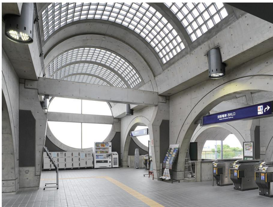
既存の照明ボックスに納められた2階コンコースの更新したLED高天井器具
