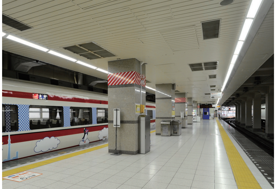
駅ホームの照明 110W蛍光灯2灯用器具から直管形LEDホーム灯器具に更新。 線路面に無駄な光が広がらないようにホーム面側に傾斜した断面形状の特注を採用
