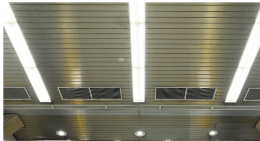
駅ホームの照明 110W蛍光灯2灯用器具から直管形LEDホーム灯器具に更新。 線路面に無駄な光が広がらないようにホーム面側に傾斜した断面形状の特注を採用
