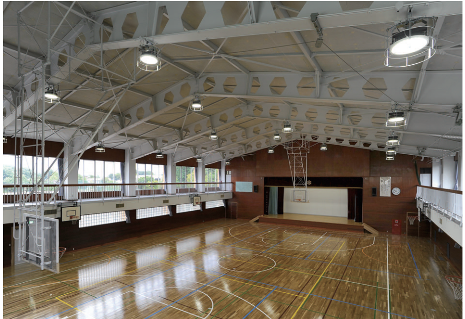
MF高天井器具から平均消費電力200WのLED高天井器具に更新した体育館(出入口側からステージ側を望む)
