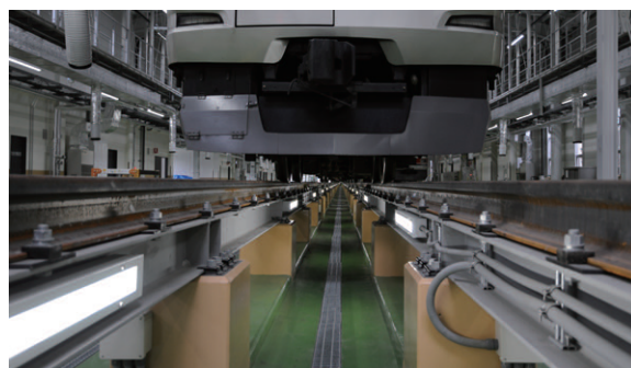
ピットにはLED一体形直付器具ビット灯を内向き配光で千鳥配置
