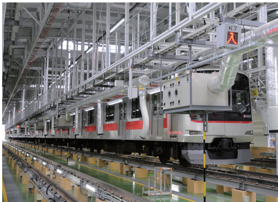
車両3編成の格納可能な元住吉車両基地。ピット、1階検査場、2階検査場にLED照明を採用し、明るく作業しやすい空間にしつつ省エネを実現
