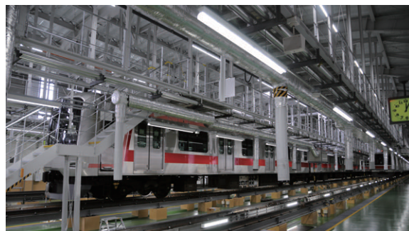
1階検査場には2階作業に支障を与えないようLED反射笠器具を採用
