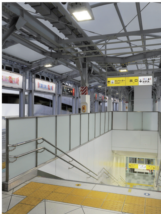
階段上部に、混雑時の危険防止としてLEDコンパクトキャノピー灯を設置
