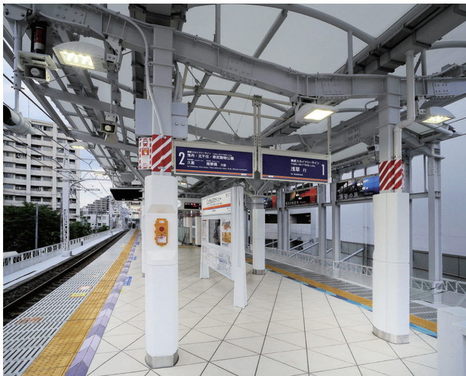
コンパクト形メタルハライドランプ投光器をLEDコンパクトキャノピー灯に更新し、大幅な省エネを実現
