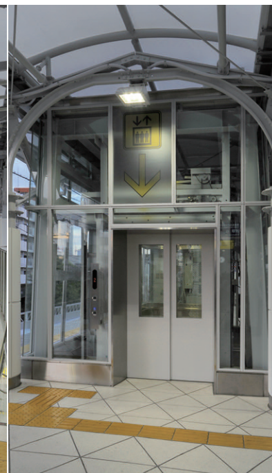
エレベーター前上部にLEDキャノピー灯を設置し、足元を明るく照射
