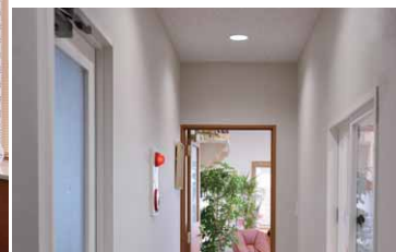
社長室前廊下はLEDライトエンジンダウンライトを人感センサーでON/OFF制御
