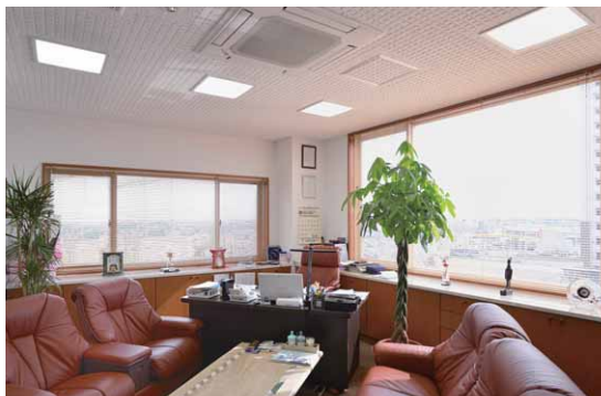
社長室には小形サイズで十分な明るさを確保した埋込穴φ450mmの一体形LEDベースライト埋込形スクエアタイプを採用
