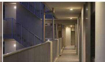
アルコーブ天井のLED照明から光が広がり各住戸の位置が把握できる共用廊下
