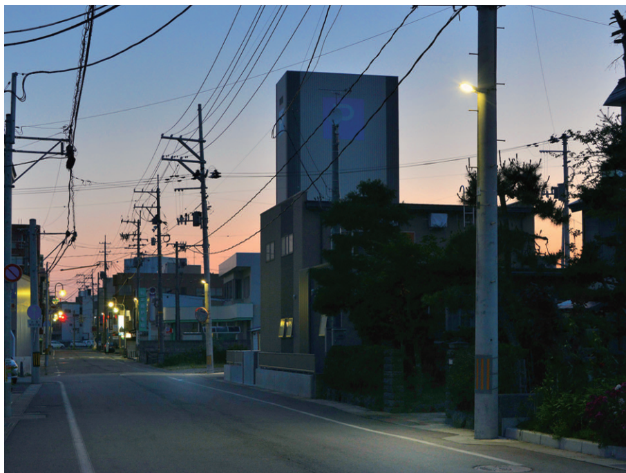
電柱の地上4.5m高に設置したLED防犯灯の点灯時
