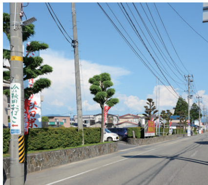
共架式のLED防犯灯に更新した昼間の生活道路
