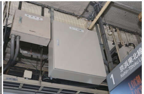
光センサーで検知した情報を照明器具の調光信号に変換する照明制御盤1と、電光表示機と連動してインジケーターの発光色情報を発信する照明制御盤2
