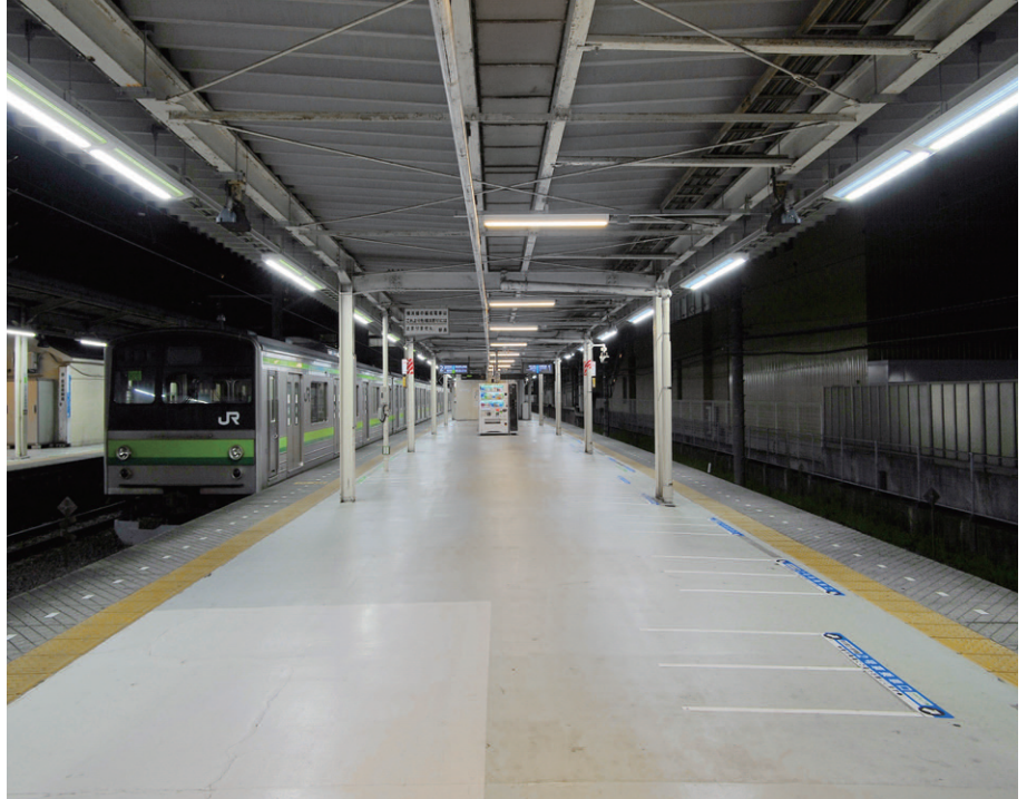
ホーム上に配置したインジケーター付LEDホーム照明(5000K)と、これに直交して設置したLEDホーム照明(3000K)
