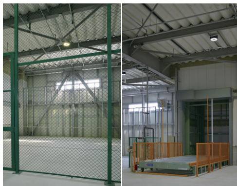
フロア隅に設けられた毒物・劇薬保管スペースのLED高天井器具
