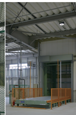
1ゾーンに1機設けられた5tエレベーター周りのLED高天井器具
