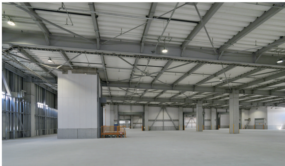
6mの高さにLED高天井器具が均等配置された倉庫スペース
