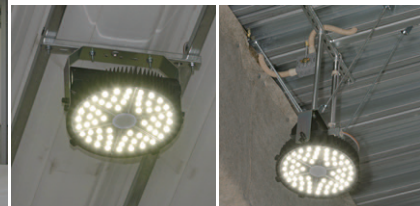
Cチャンネルに直付けされたLED高天井器具
