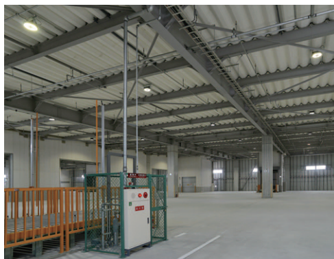
1ゾーンに2機ずつ設けられた垂直搬送機周りのLED高天井器具
