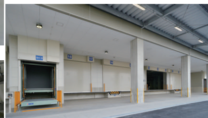
1階プラットホーム前の底下に採用されたステンレスの防水の直管形LEDベースライト
