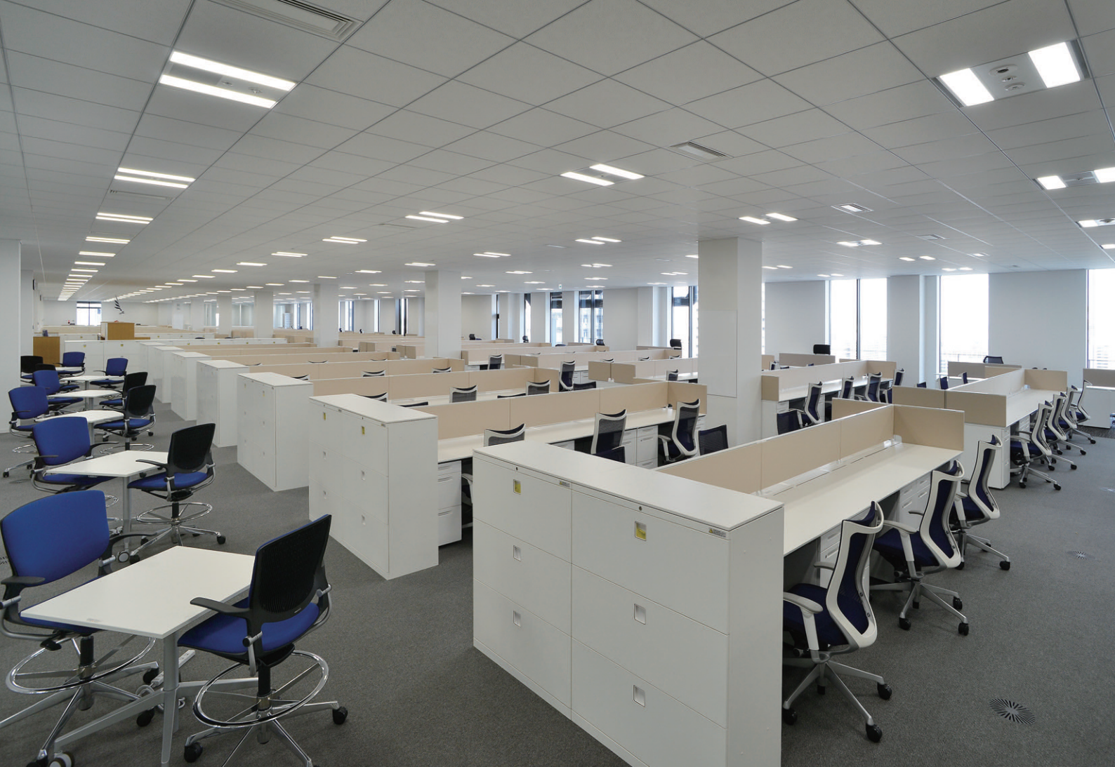
システム天井用LEDベースライトとスマートアイセンサー、明るさセンサーを組み合わせ、徹底してムダを省く最新のセンシング技術を導入した執務室
