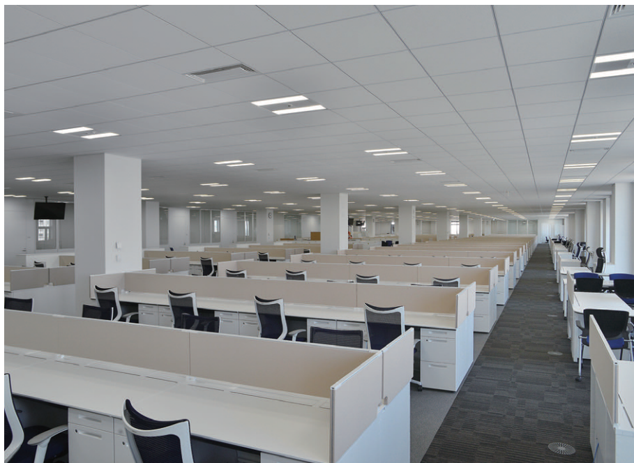
窓側の執務スペースは明るさセンサーによる昼光利用制御で省エネ
