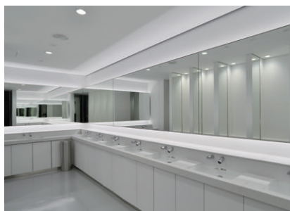
社員用女子トイレのLED照明
