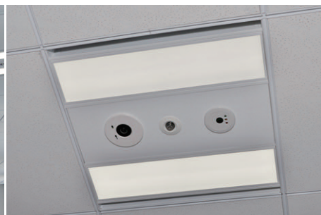
システム天井用LEDベースライト+スマートアイセンサー+明るさセンサー
