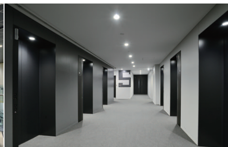
エレベーターホールのLED照明
