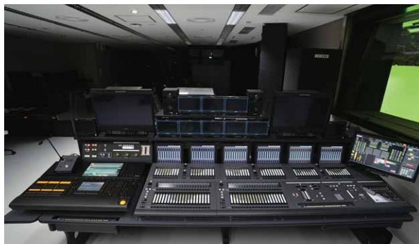
副調整室内の調光操作卓
