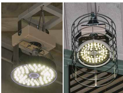
大講義室のLED高天井器具 体育館のLED高天井器具
