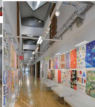
左右の廊下壁面は高演色性のLEDスポットライトで展示品を照射
