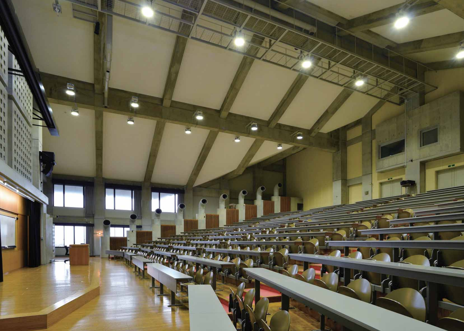
大講義室の照明 瞬時点灯・再点灯が可能なLED高天井器具を採用。同時に長寿命60,000時間によりランプ交換のメンテナンス費を軽減
