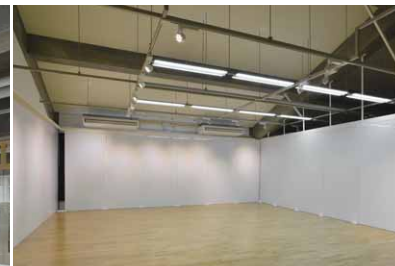
ギャラリーは一体形LEDベースライト薄形タイプで地明かりを、LEDスポットライトで壁面を照射
