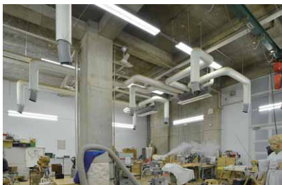
木影アトリエは天井以外に壁面にも一体形LEDベースライト薄形タイプを配置
