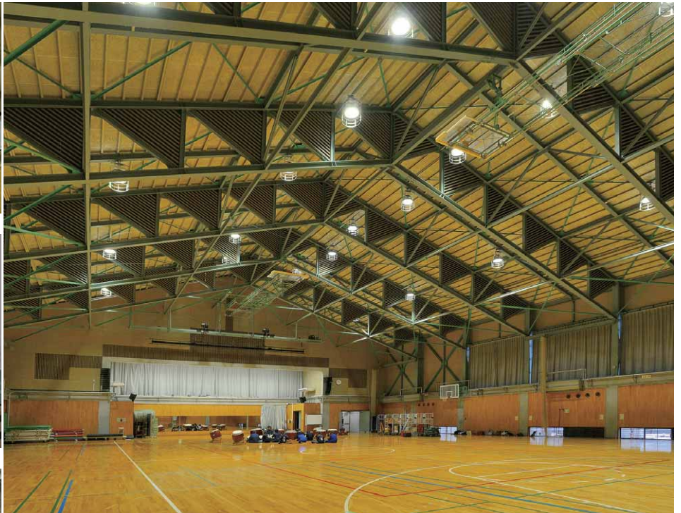
体育館の照明 LED高天井器具を左右対称配置。器具は電動昇降装置付とし、床面でのメンテナンスが可能
