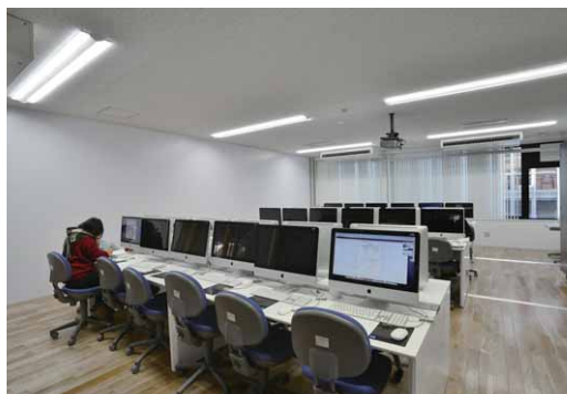
一体形LEDベースライト薄形タイプによるCAD室の照明
