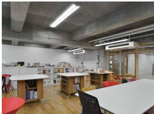
デザイン実習室の一体形LEDベースライト薄形タイプによる照明
