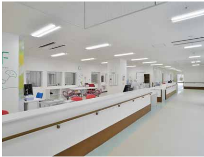
LED薄形タイプを均等配置したナースステーション
