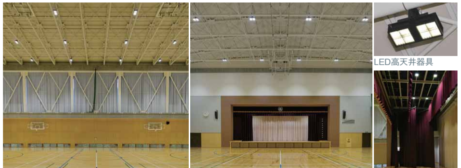
館内横面から見たLED高天井器具
