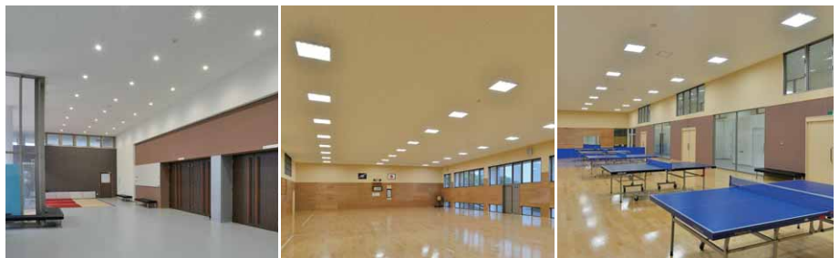
2階エントランスホールのLEDダウンライトによる照明
