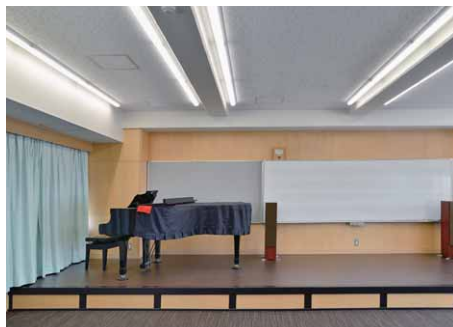
LEDベースライトAQシリーズによる音楽室の照明
