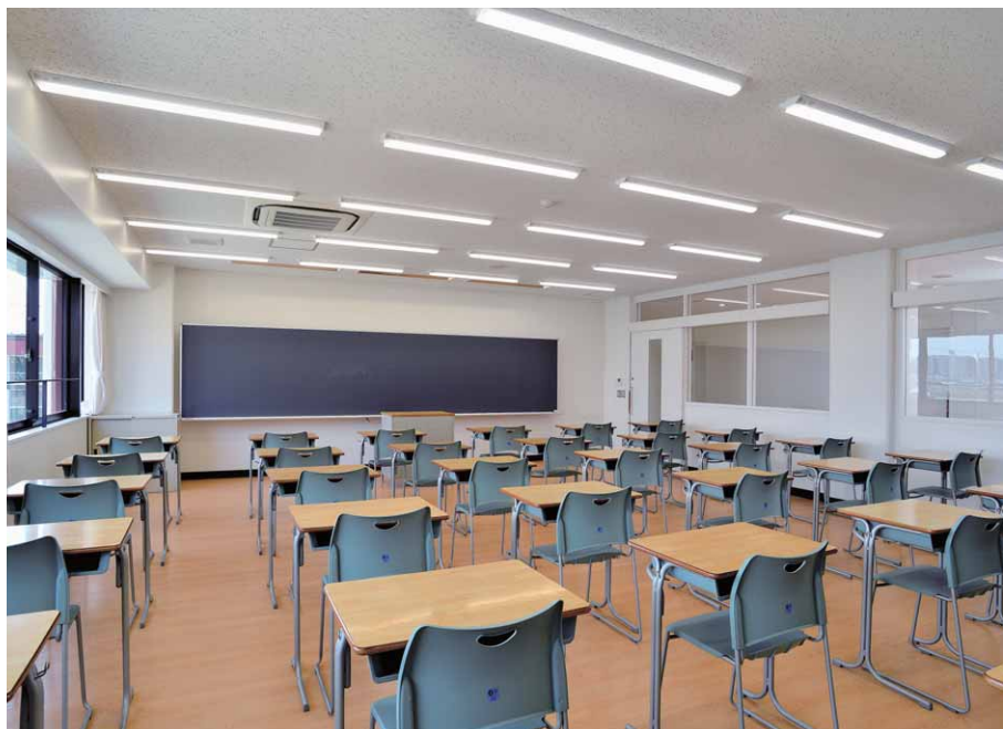
一般教室にはスリムなデザインと天井面も明るく照射するLEDベースライトAQシリーズを採用
