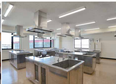
家庭科室のAQシリーズによる照明
