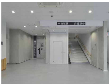
LED一体形ダウンライトを配置したエントランスの照明
