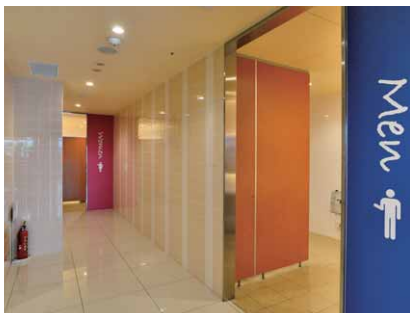
トイレ入口周辺のLED一体形ダウンライト
