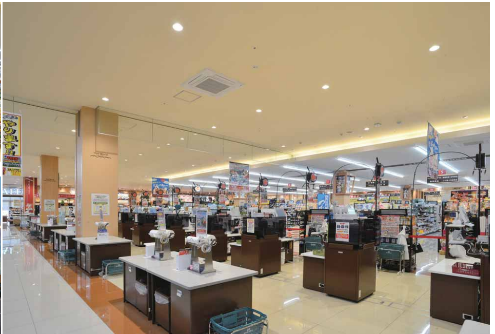
LED一体形ダウンライト温白色が採用されているレジまわりの照明
