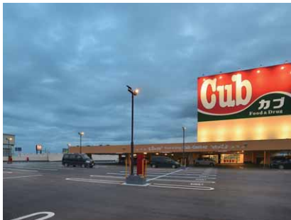
LED小形投光器による2階駐車場の照明
