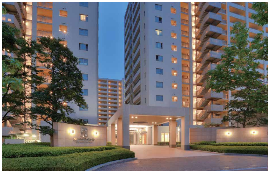
エントランスから1番館、2番館、さらに中央奥に3番館を望む。電球色のLEDブラケット、LEDダウンライトによって暖かみのある生活空間を演出
