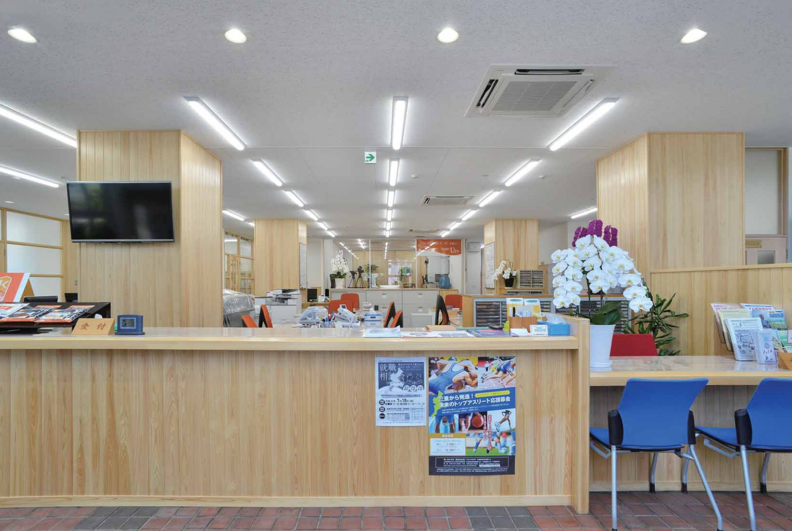
事務所の照明 ベースライトにはLEDベースライトAQシリーズ直付形、カウンター上にはLED一体形ダウンライトを配置
