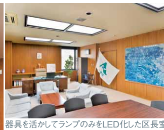
既存のシステム天井用蛍光灯器具から直管形LEDベースライトシステム天井用器具(特注)に更新した執務室
