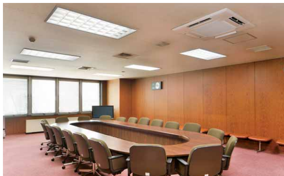
既存蛍光灯器具を活かして直管形LEDランプに置き換えてLED化
