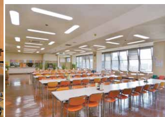
食堂に設置したLED特注器具
