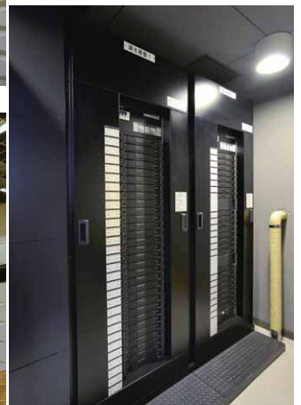
インテリジェント形調光器盤「PLUG-IN DIMSTAR III」
