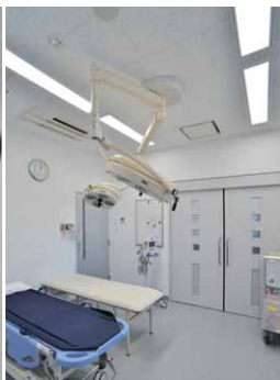
救急室に採用した一体形LEDベースライト薄形タイプ
