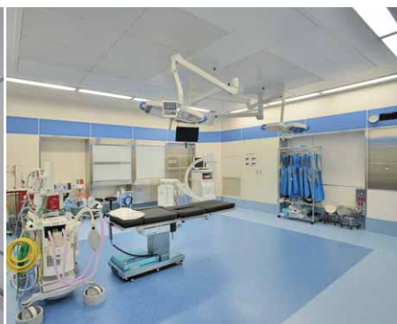
LEDクリーンルーム用器具を採用した手術室の照明
