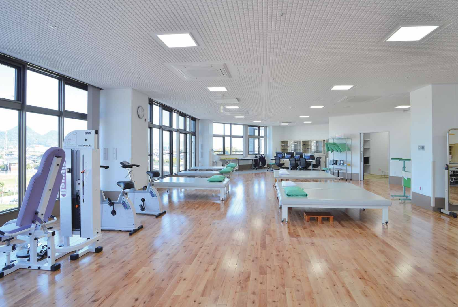
リハビリテーション室の照明 LEDベースライト埋込スクエア器具乳白カバー付を均等配置。手術後のケアがスムーズに行える光環境を確保
