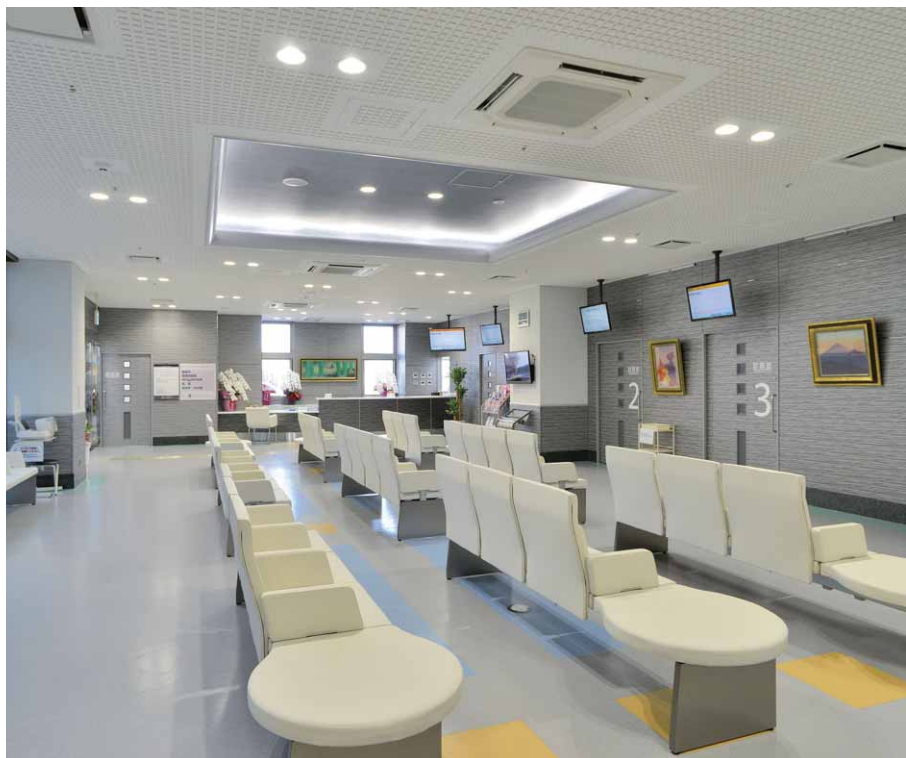
総合待合室の照明 ベース照明にLEDライトエンジンダウンライトを均等に配置し、掘り上げ天井には間接照明としてLEDベースライト笠なし器具を設置
