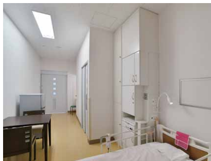
病室のLED照明。ベッド灯はLEDアーム式ベッド灯を採用
