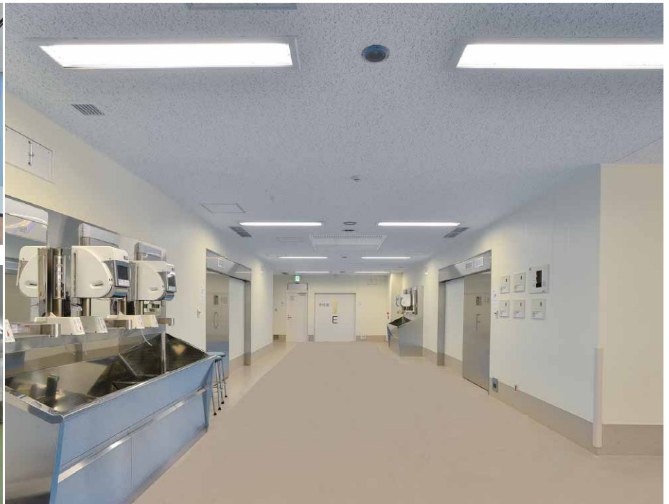
手術ホールの照明 クリーンルーム用埋込ガラスカバー付器具を採用
