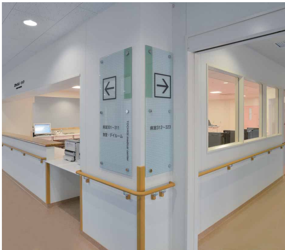
スタッフステーションの照明 廊下にはLEDライトエンジンダウンドライト、執務室はHf蛍光灯スクエア器具を採用
