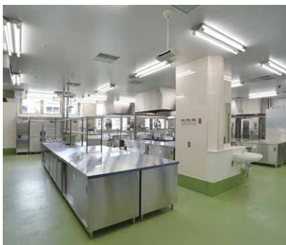
調理室のステンレス防水器具による照明
