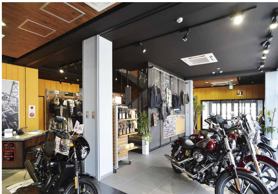
ハーレーダビッドソン1階入口付近より新車展示コーナーを望む。 照明器具は天井色に合わせて選ばれた黒のライティングレール+LED一体形スポットライト黒色
