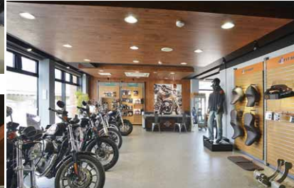
ウッディ素材の吊り天井にLED一体形ダウンライトを整然と並べたハーレーダビッドソン／2階中古車コーナー
