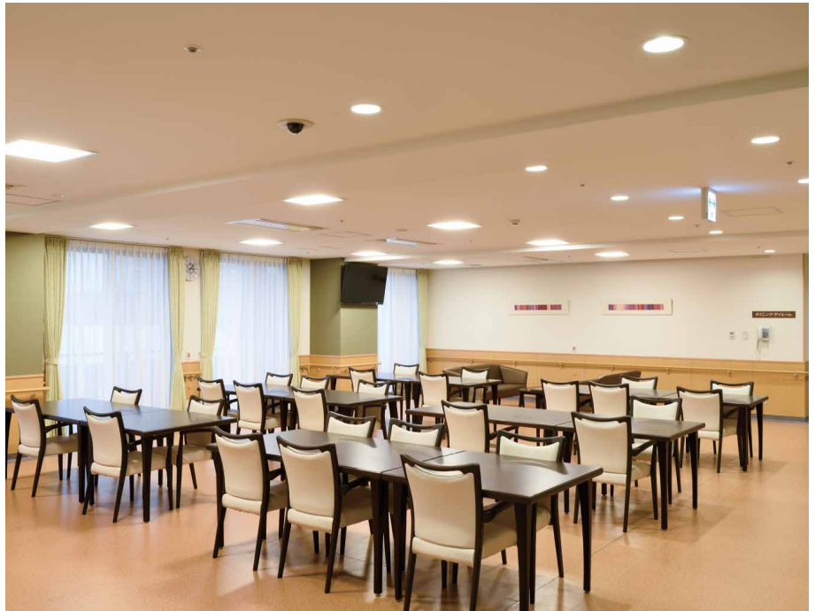
ダイニング・ディールームの照明 FHP45形蛍光灯×4灯用器具相当のLEDベースライトスクエア器具埋込形を中心に配置
