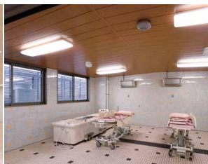
Hf32形×2灯用タイプ防湿・防雨直付器具を4カ所に配置した3階機械浴室
