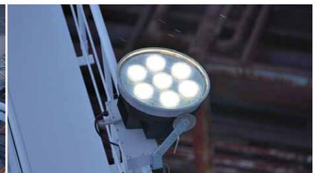
ステージ内側に設置した1.5kWメタルハライドランプ投光器相当のLED投光器
