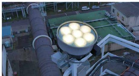
ステージ外側に設置した1.0kWメタルハライドランプ投光器相当のLED投光器
