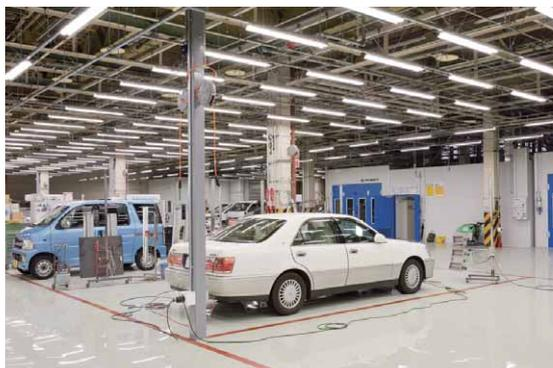
軽補修ブースの照明 光源を3.7mの高さに間隔を詰めて設置してひときわ明るい作業環境を確保
