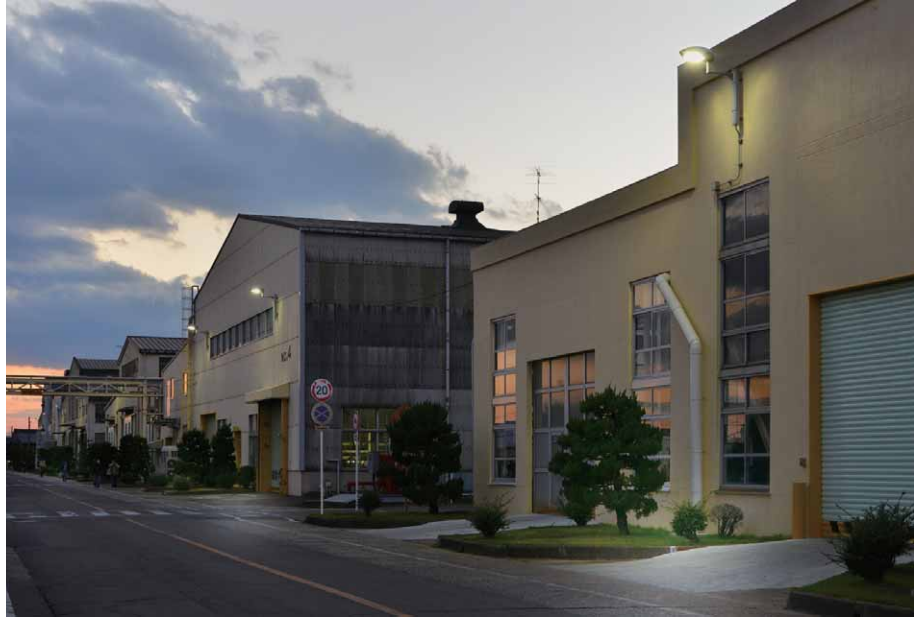
生産工場の建屋出入口外壁面上部に設置されたLED道路灯（改良形）
