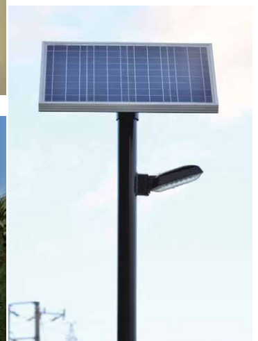
LEDソーラーライト（鉛蓄電池）
