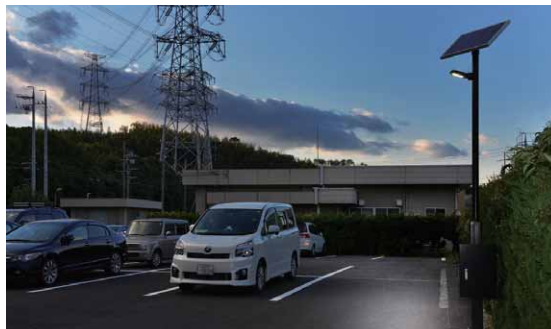
LEDソーラーライトが設置された駐車場の夜間照明
