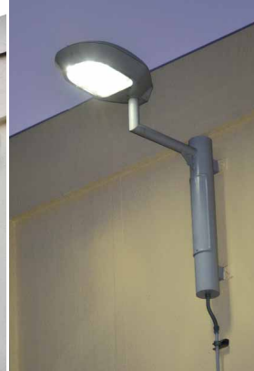
点灯時の改良形LED道路灯
