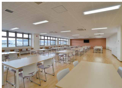
直管形LEDベースライト直付下面開放器具(2灯)を広いピッチで配置し落ち着いた空間を演出した食堂
