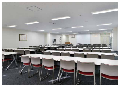
直管形LEDベースライト直付下面開放器具(2灯)を狭いピッチで配置し明るさを高めた大会議室
