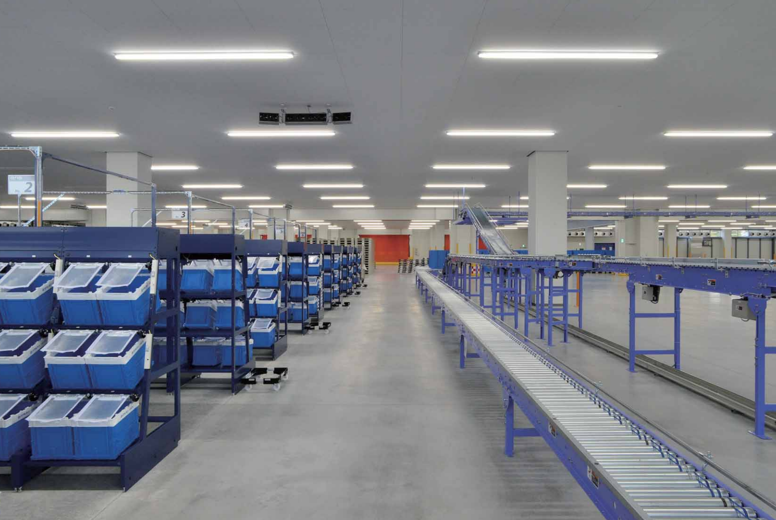
天井高約4mの3階フロア。天井方向にまで光が回るLEDベースライトAQシリーズが、白い天井からの反射光も含めて空間全体の明るさをアップ
