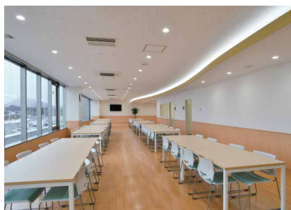
休憩室はLEDライトエンジンダウンライトと間接照明によってリラックスできる空間を演出
