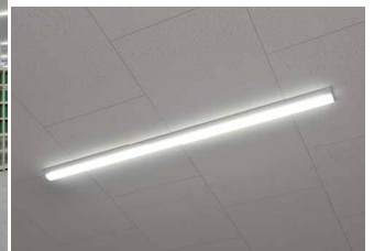
倉庫エリアの主照明となる器具長さ2448mmのLEDベースライトAQシリーズ110タイプ
