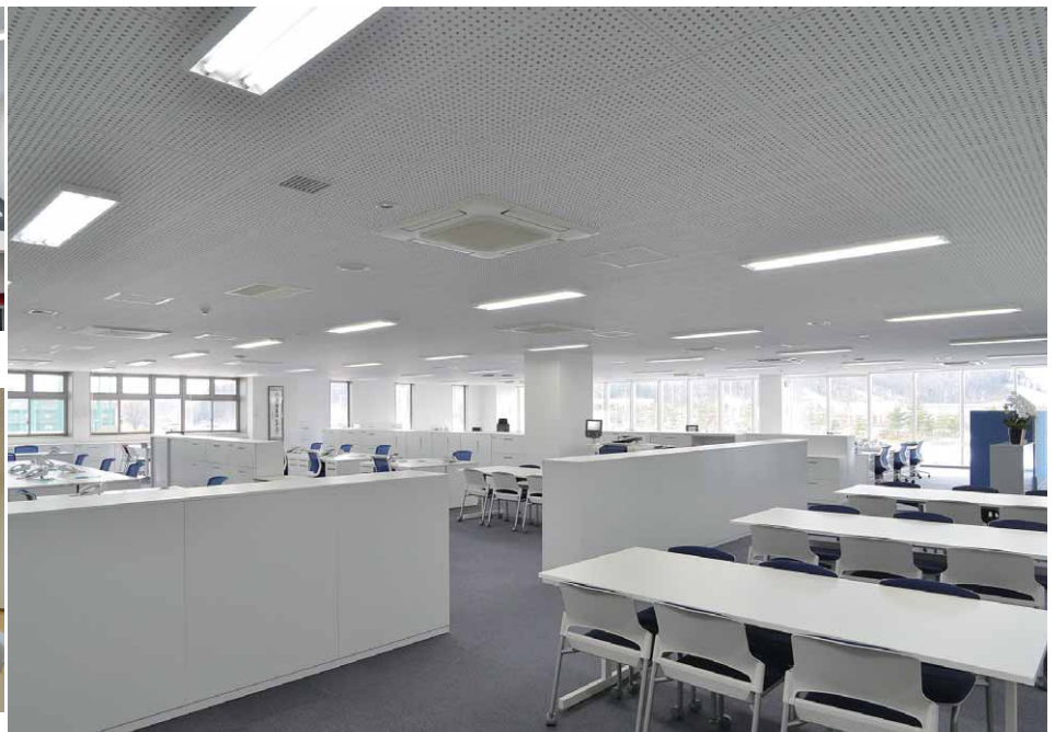
2階事務室では、直管形LEDベースライト直付下面開放器具(2灯)を採用しデスクワークに必要な光が均質に届くよう配置
