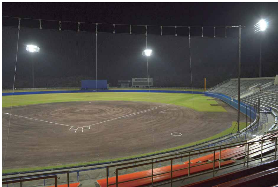
バックネット裏からの照明風景 LED投光器を搭載した照明塔によりグラウンドを明るく照射
