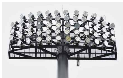
LED投光器搭載の照明架台部
