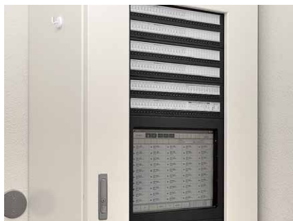
LED照明スイッチ盤
