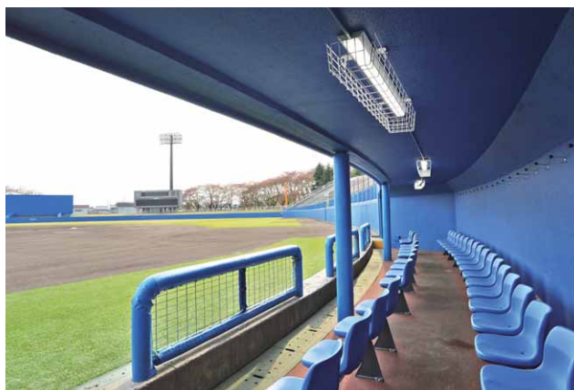
ダッグアウトの照明に採用されたLEDベースライトTENQOOシリーズ
