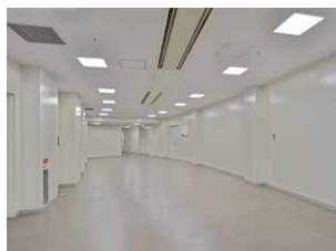
内装に合わせたクリアで居心地の良い廊下のLED照明
