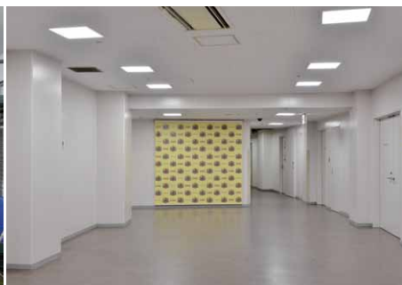
囲みインタビューなども行われる廊下のLEDベースライトスクエア器具埋込形の照明
