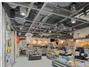
レースウェイを用いて設置されたタイガースショップのLEDシーリングダウンライト
