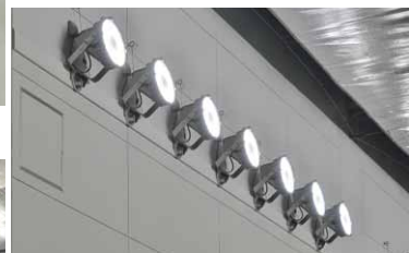
壁面に設置したLED投光器群
