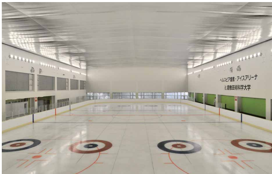
スケートリンクの正面側から奥側を望む 両サイドにLED投光器を54台ずつ(計108台)設置し、照射角を天井面に向けて間接照明にすることで有害なグレアを防止
