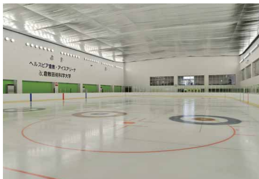
LED投光器による間接照明をリンク奥側から正面側を望む
