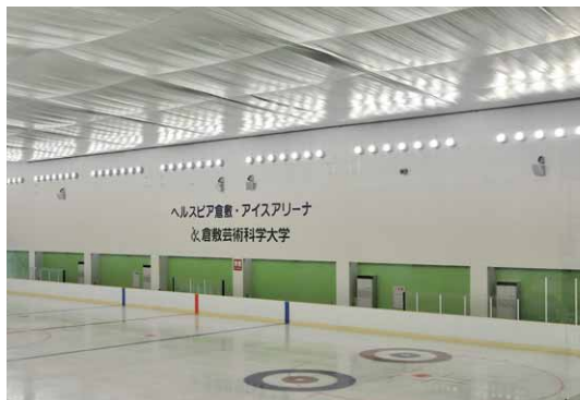
床面より9m高に均等設置したLED投光器群
