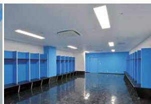
1階選手更衣室のLED照明
