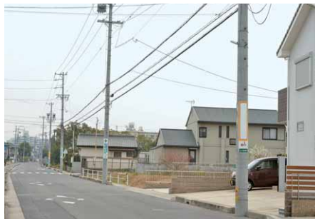
半田市乙川若宮町付近の生活道路の更新したLED防犯灯
