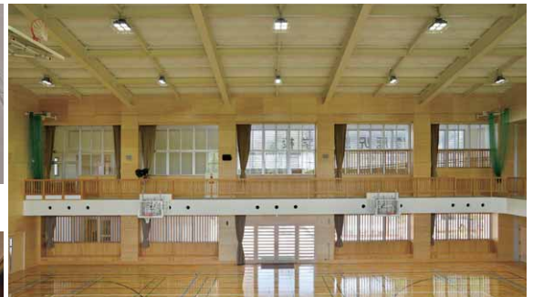
屋内運動場の側面側から対向面側を望むLED高天井器具
