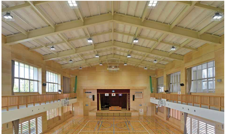
屋内運動場の照明 LED高天井器具(下面ガード+体育館用ガード付)を均等配置
