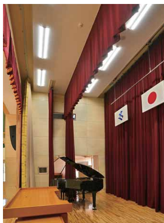
LED薄形ベースライト調光形を設置したステージの照明
