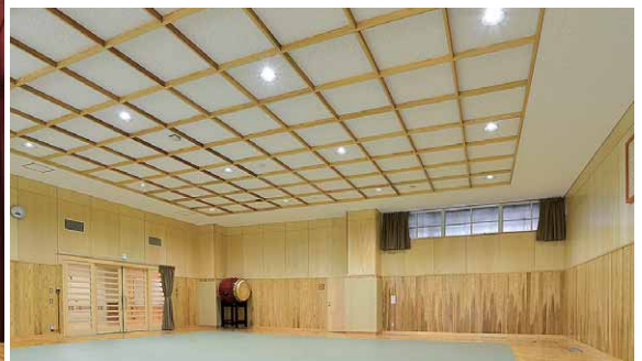
武道場の照明はFHT57W×3灯用器具相当のLED一体形ダウンライト7500シリーズを採用
