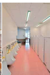
園児トイレのLED照明
