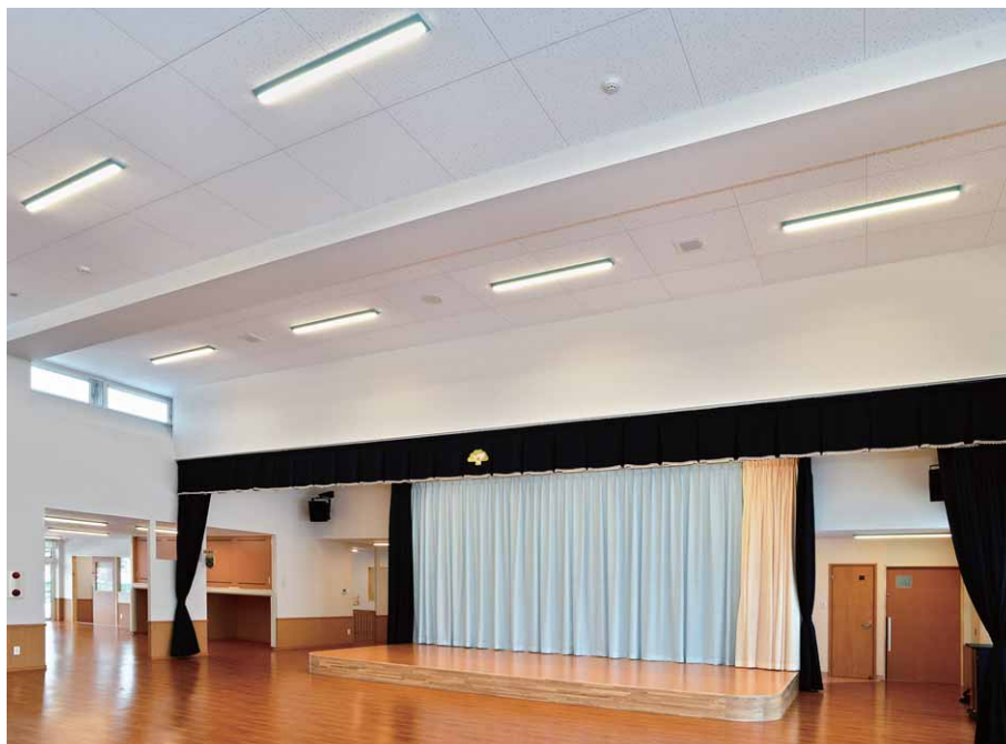
ステージ付遊戯室の照明 本体を緑色に塗装した親しみのあるLEDベースライト TENQOOカラーシリーズ直付器具を均等配置
