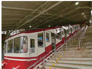
高野山駅ケーブルカー乗り場ホームの照明
