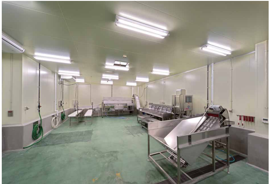
魚の下処理を行う処理室。防湿・防雨形の直管形LEDベースライトを均等配置し、手元にも十分な明るさを確保
