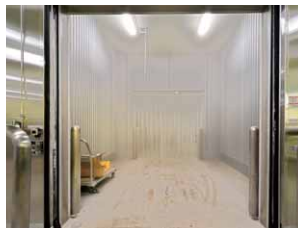
-25℃の冷凍室に設置された直管形LED冷凍倉庫ベースライト
