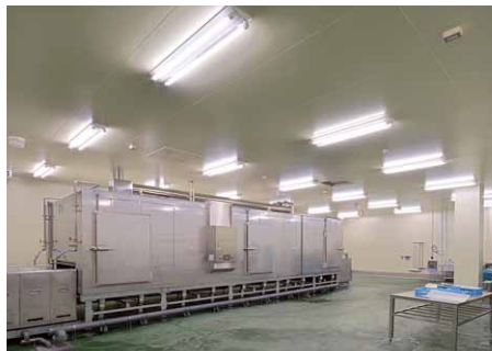
室温18℃に保たれた第2加工室に配置された防湿・防雨形の直管形LEDベースライト
