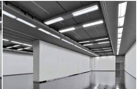
直管形LEDベースライト3灯用(特注)を壁面にライン状に配置し、その中央を交差する形で2台を並列配置した第2・第3展示室(左)と第4・第5展示室(右)
